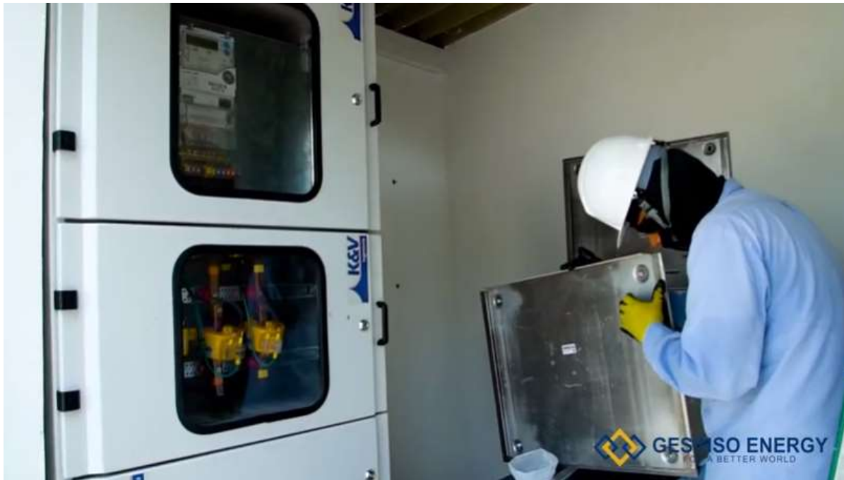
Figura 5 planta generadora instalada con tecnología fotovoltaica (Pinto, 2020)
