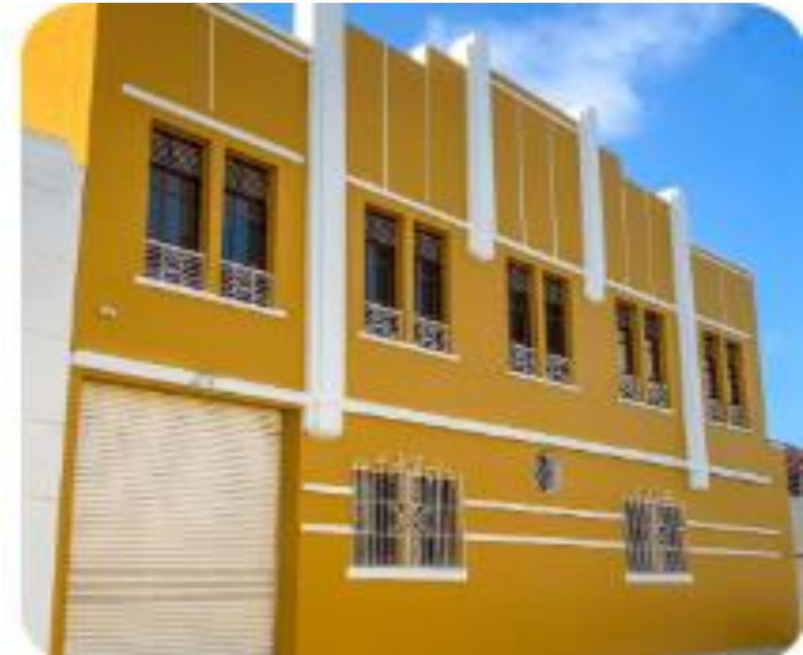
Figura 1. Fachada de empresa Empaquetaduras y Empaques
