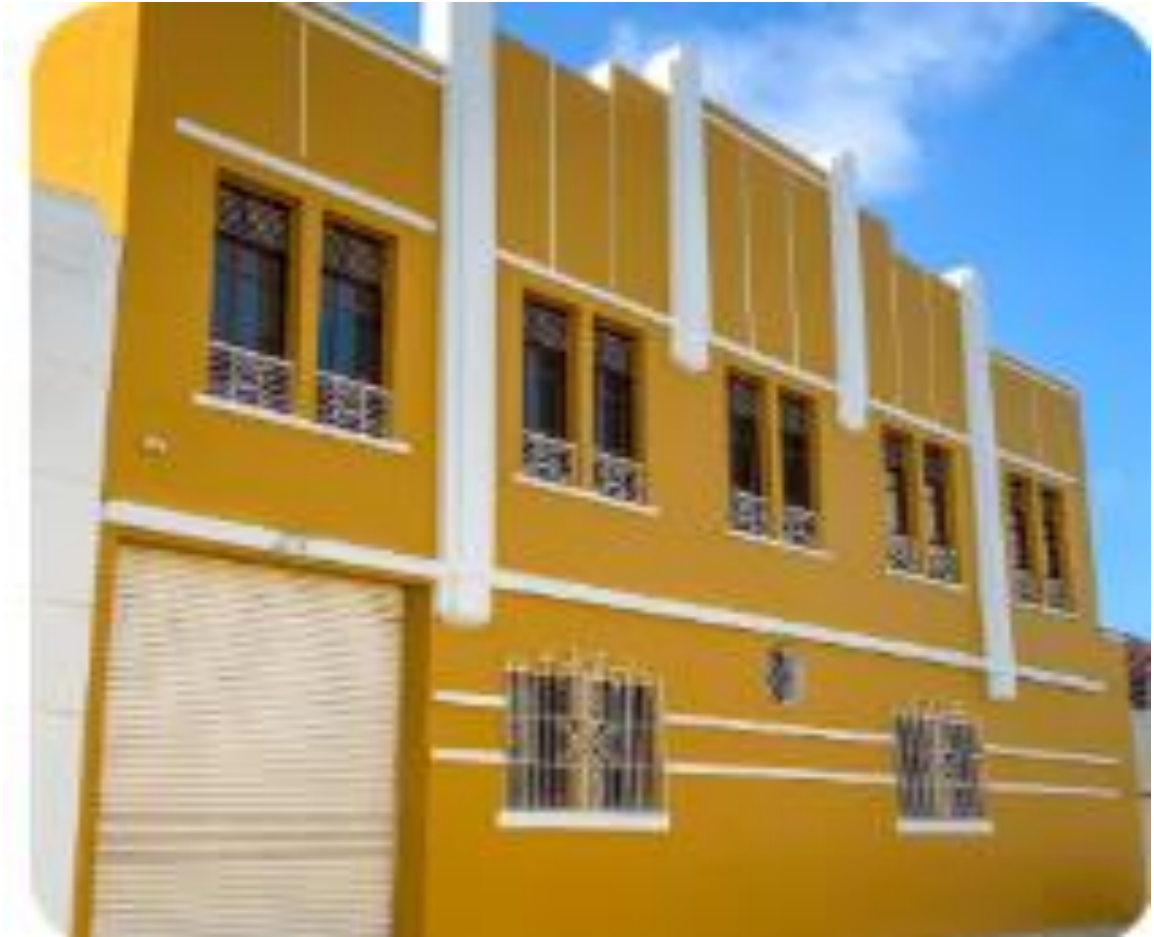
Figura 1. Fachada de empresa Empaquetaduras y Empaques
