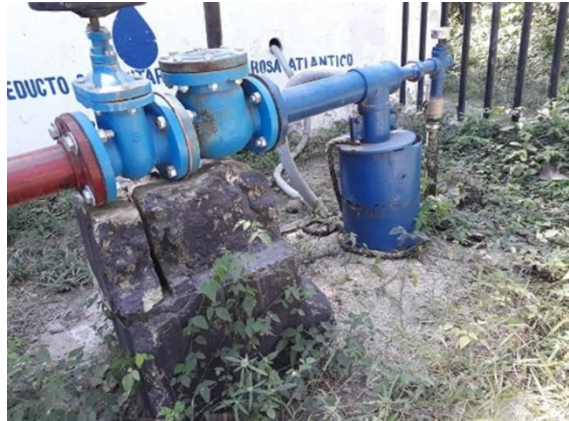
Figura 10. Pozo subterráneo y bomba de captación.
